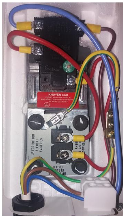
Lắp đặt thanh đốt đơn
