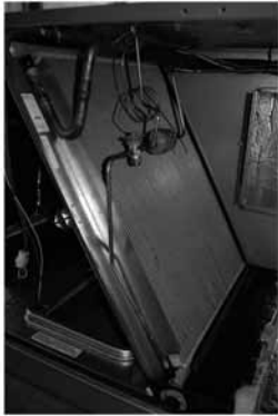
Fan Proving Switch
