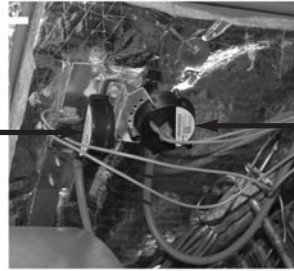
Fan Proving Switch
