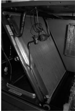
Fan Proving Switch
